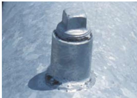
Las salidas soldadas de aspersores a lo largo de la tubería añaden resistencia y durabilidad.
